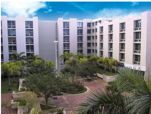
Vista del patio exterior
